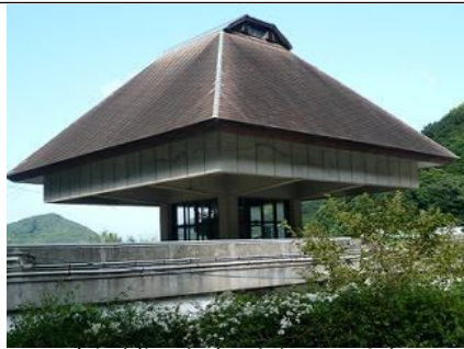
変な建物ですが40年経っています
