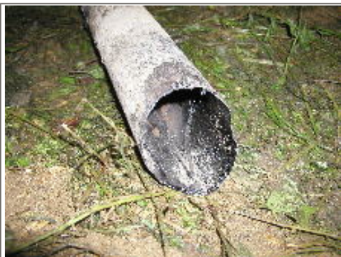
煙突撤去。内部に竹酢液。
