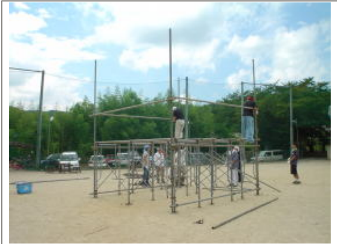
手すりも付けます
